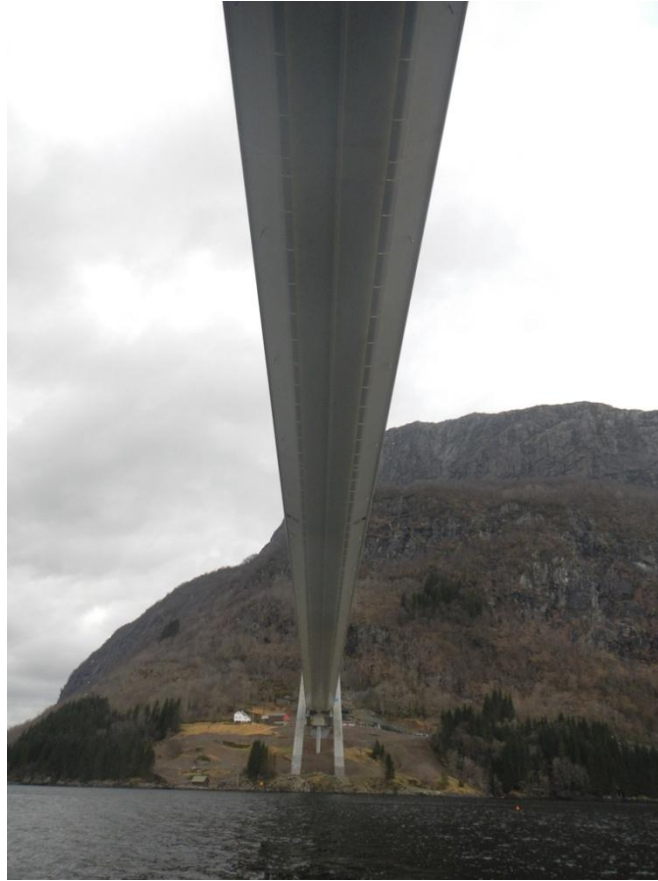
Die neue Brücke bei Dale mal von unten
